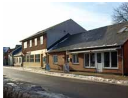
Den sydlige del af Jernbanegade. Oprindeligt var husene her et-etages huse med bolig og butik evt. værksted. Mange huse er i tidens løb udvidet med endnu en etage.
