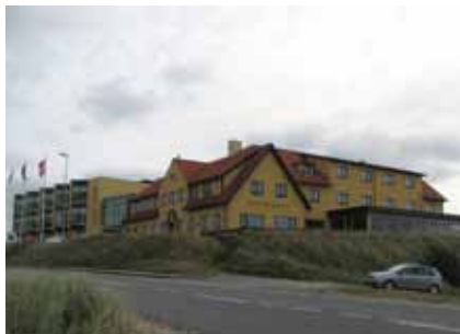
Nymindegab Kro med den gamle værelsesfløj mod syd og den nye tilbygning med de markante glaspartier mod øst.
