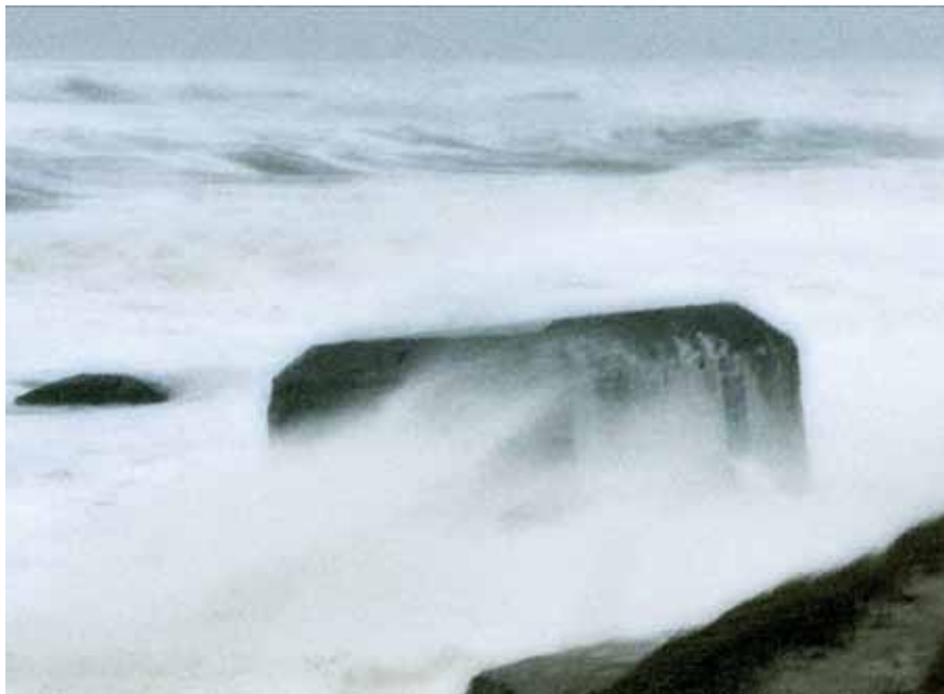
Elementerne slider hårdt på Kryle-bunkerne, når stormen rigtig tager fat. Billedet er taget i orkanstyrke i december 2011.
