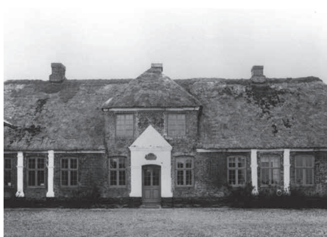
Hovedbygningen før den store ombygning i 1941.
